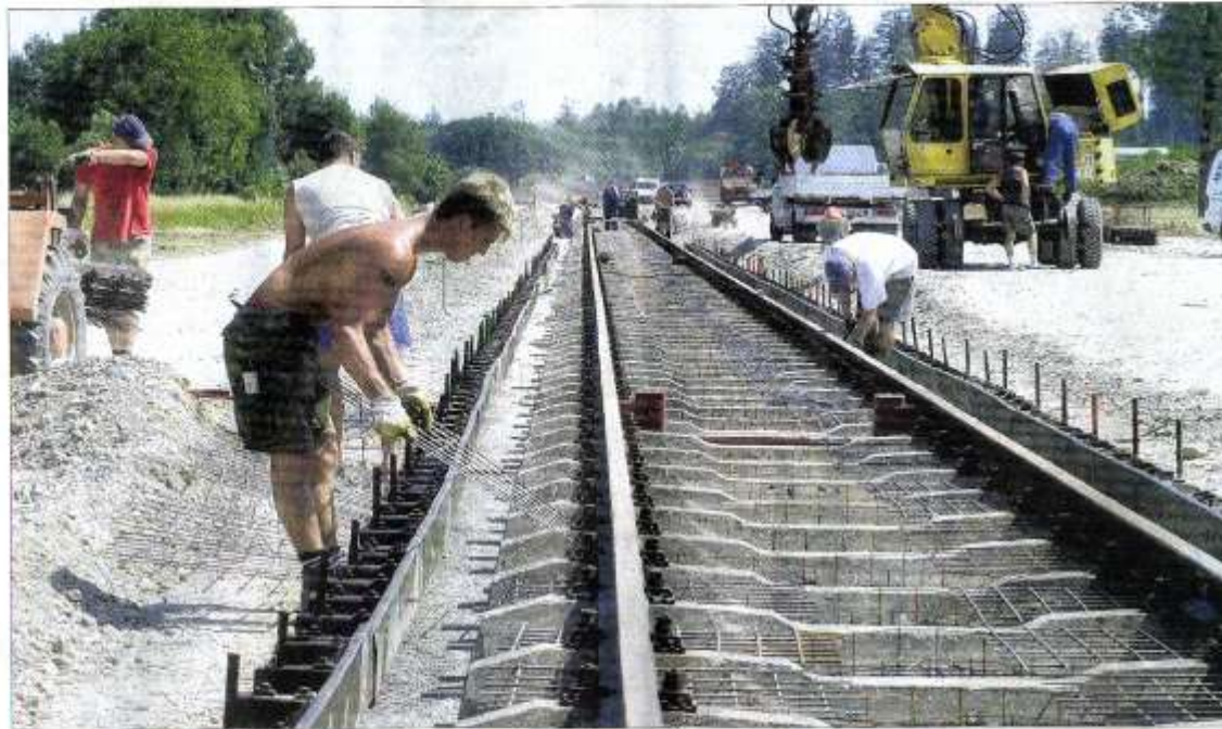
Ungeachtet der Drohungen gegen den Unternehmer Herwig Lautenbacher gehen die Bauarbeiten für die Holzverladestelle bei Fischach zügig voran. In der kommenden Woche soll das neue Gleis durch eine Weiche mit den Schienen der Staudenbahn verbunden werden. Bild: Merk
